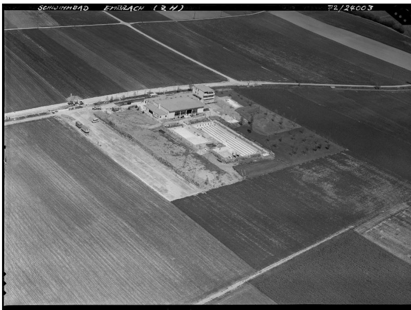
Nouvelle piscine d'Embrach, 1972. ETH Library Zurich, Image Archive / Com_F72-24003
